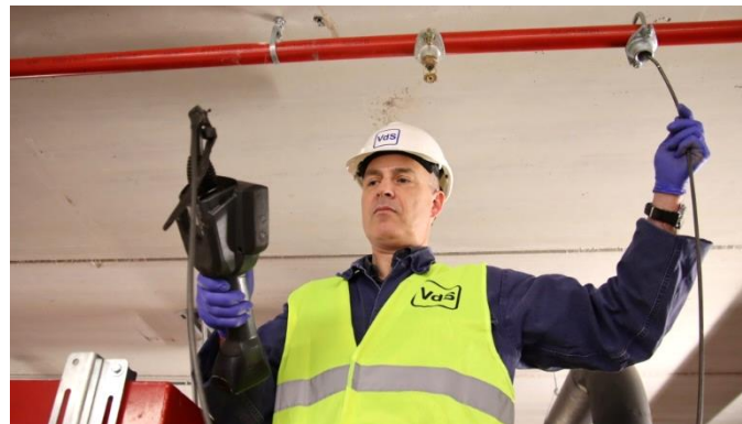
Inspectie van de leiding met behulp van een endoscoop
