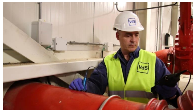
De wanddiktemeting wordt uitgevoerd met ultrasone apparatuur
