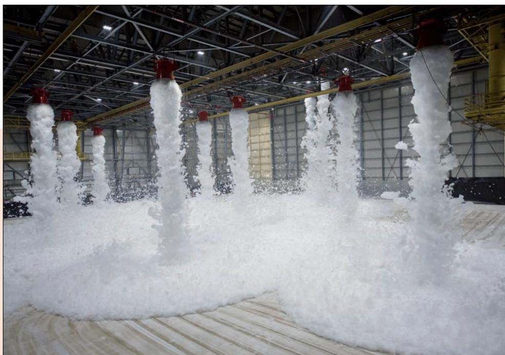
Auslösung einer Schaumlöschanlage in einem Hangar
