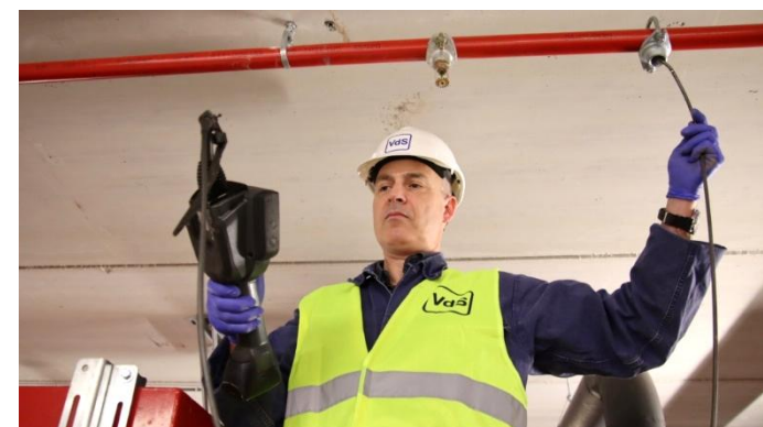
Inspectie van de leiding met behulp van een endoscoop
