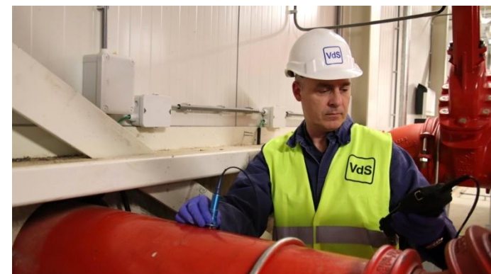
De wanddiktemeting wordt uitgevoerd met ultrasonore apparatuur
