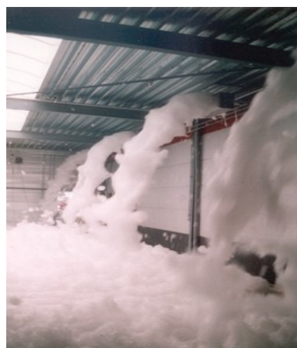
Figuur 8.7 en 8.8 Geactiveerde lichtschuimsystemen
