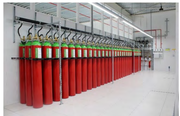
Figuur 6.3 Inertgas blussysteem (IG541, IG55, IG100) Bron: Ansul Solutions
