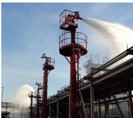
Figuur 8.4 en 8.5 Blustorens met zwaarschuim-monitoren
