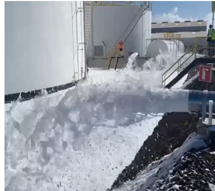
Figuur 8.6 Tankputbeschuiting met middelschuimstraalpijpen
