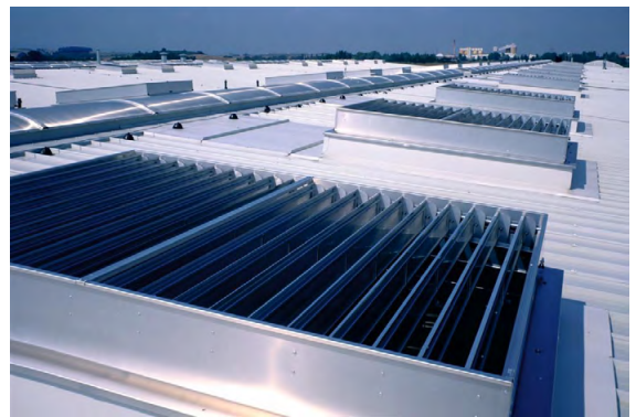
Figuur 10.1 Rookluiken op het dak
